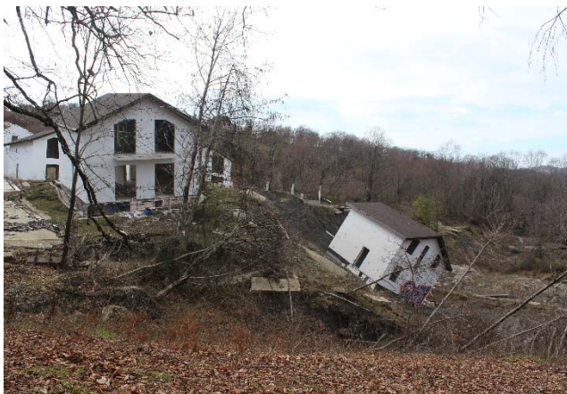
Рис. 5. Вид на коттеджи после оползня и разрушения поселка
